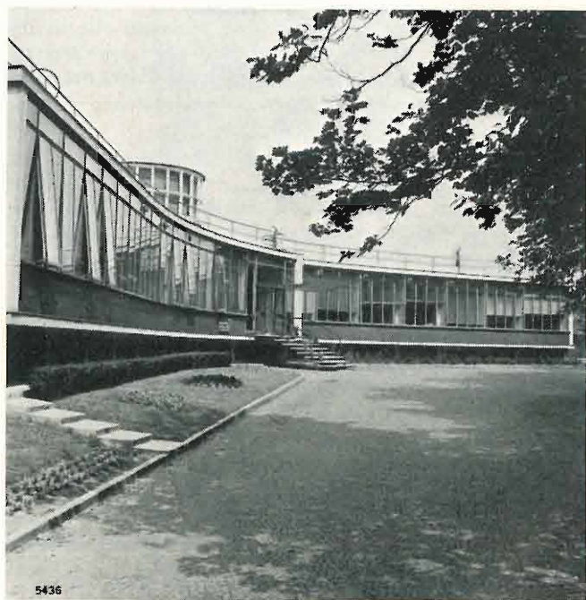
Fig. 2. — Veduta esterna della facciata del Centro di Controllo nel Parco di Monza.
