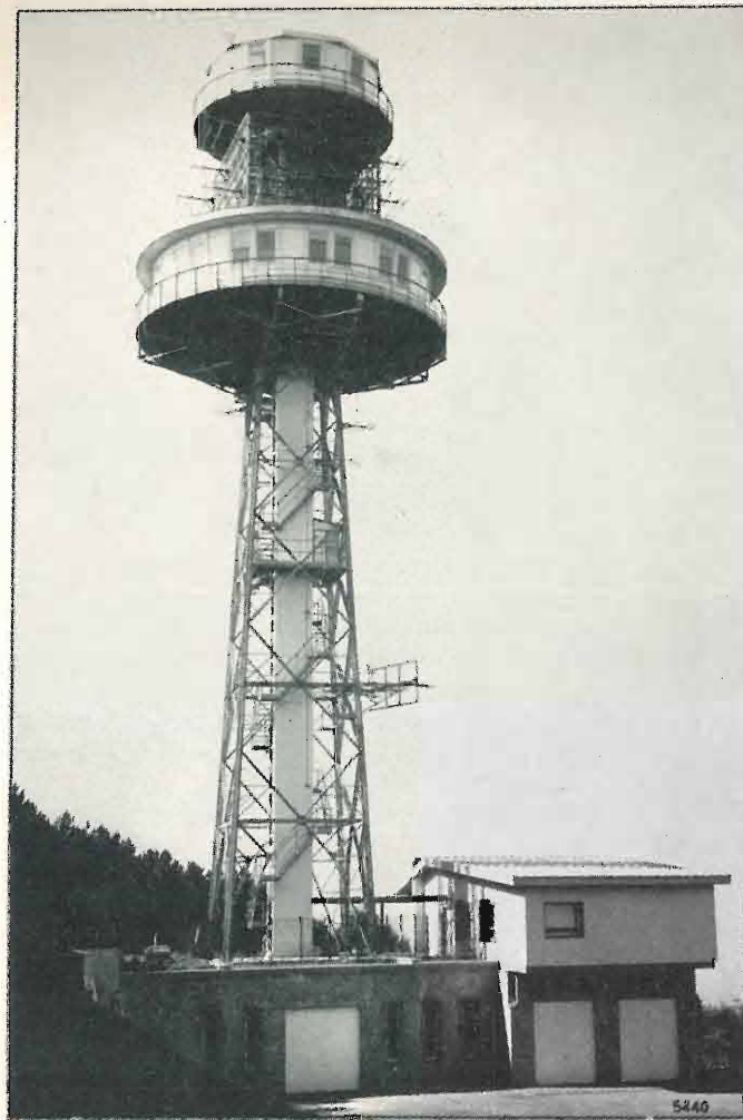
Fig. 6. — Centro di Controllo Sussidiario di Sorrento. Sulla sommità della torre sono visibili la torretta per misure di campo elettromagnetico, le antenne rotanti VHF e UHF e la piattaforma sulla quale trovano posto le apparecchiature per gli Ascolti e Misure di Frequenza.
