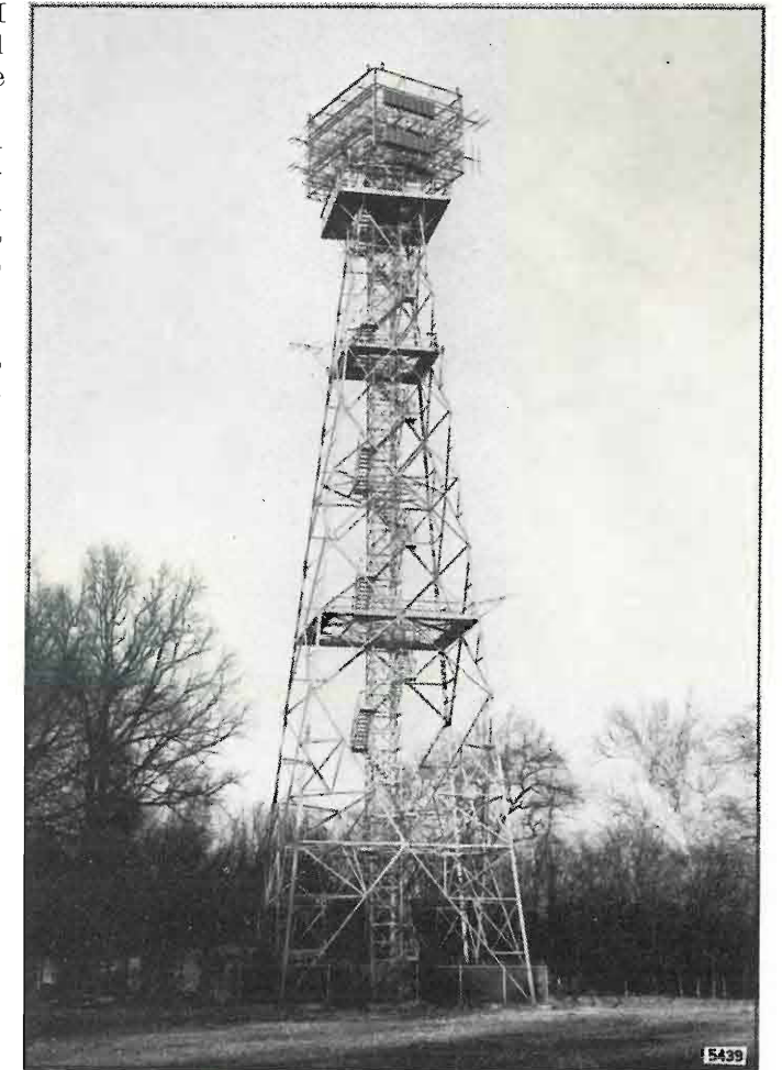
Fig. 5. — Vista della torre che sostiene a oltre 50 metri dal suolo, le antenne riceventi VHF e UHF di Monza.
